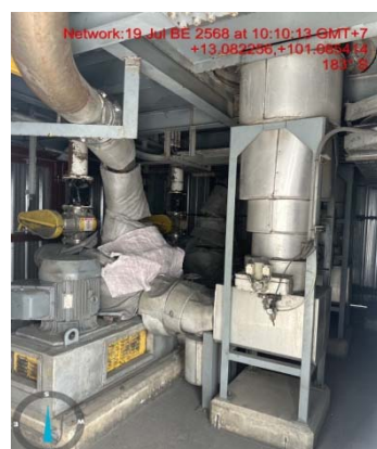
รูปที่ 7 ระบบควบคุม SO 2 และ HCl แบบ Dry-absorption System
