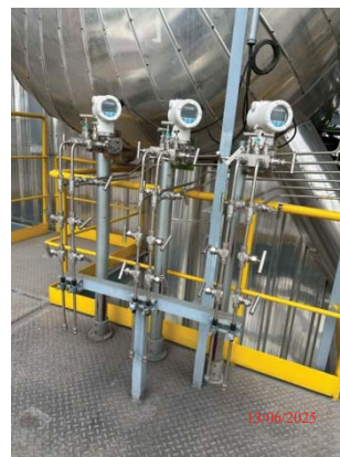
รูปที่ 76 อุปกรณ์ตรวจวัดความดันของหม้อไอน้ำ
