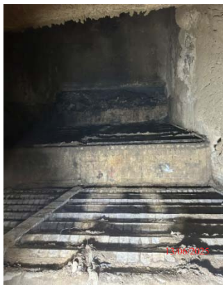
รูปที่ 5 เตาเผาแบบตะกรับ (Stoker Grate Firing)
