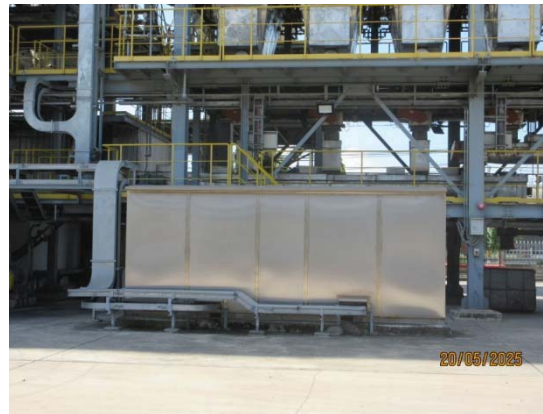
รูปที่ 16 ระบบดูดซับด้วยผงถ่านกัมมันต์ (Odor Adsorption Unit)
