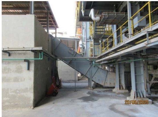
รูปที่ 56 ระบบลำเลียงเชื้อที่เป็นระบบปิด
