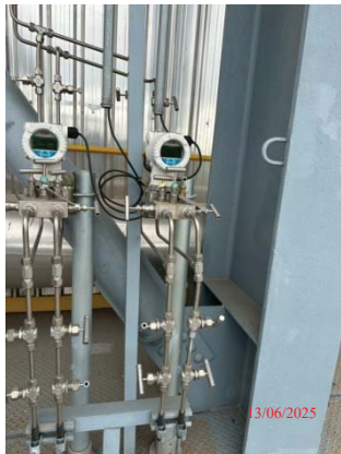
รูปที่ 77 อุปกรณ์ตรวจวัดอัตราการไหลของหม้อไอน้ำ
