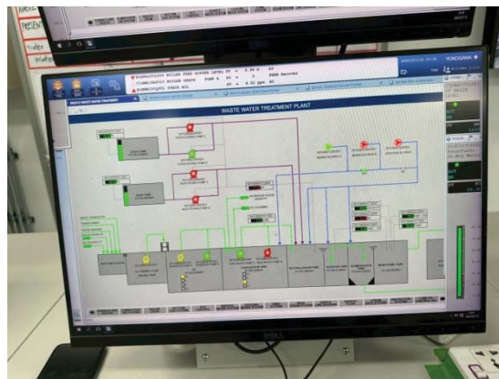
รูปที่ 38 หน้าจอ DCS แสดงผลการตรวจวัดคุณภาพน้ำทิ้งแบบอัตโนมัติ (Online) ที่ Control Room
