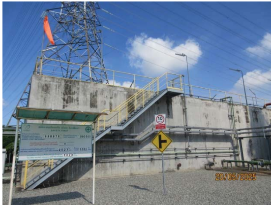
รูปที่ 22 ถังสำรองน้ำใช้ ขนาด 1,100 ลูกบาศก์เมตร
