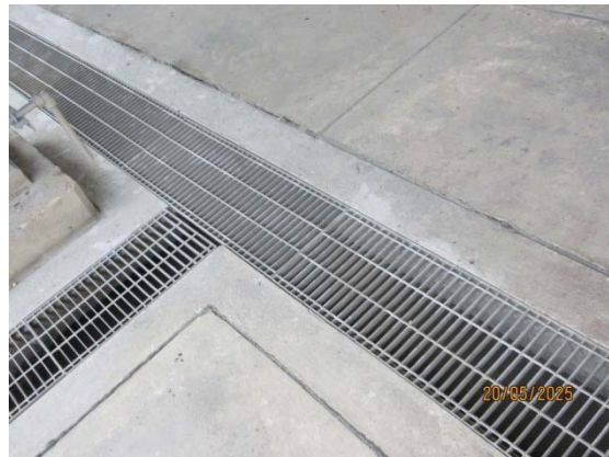
รูปที่ 28 รางระบายน้ำฝนไม่ปนเปื้อน
